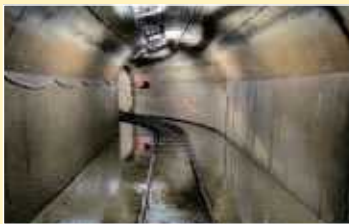
用水路内に軌条設備を敷設し、軌陸車や運搬台車により重機材や作業員を運搬
