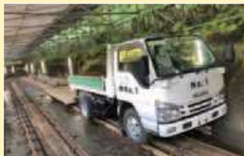
用水路内に軌条設備を敷設し、軌陸車や運搬台車により重機材や作業員を運搬
