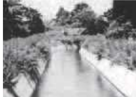
完成した幹線導水路
