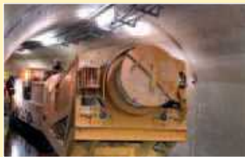
用水トンネル内でのコンクリート運搬状況
