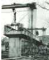
建設中の斉藤川水路橋
