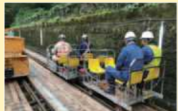
用水路内に軌条設備を敷設し、軌陸車や運搬台車により重機材や作業員を運搬
