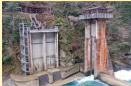
らせん階段 新設 操作室 更新 取水工と土砂吐工の全景（改修後）
