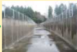
【改修後】(目地補修)
