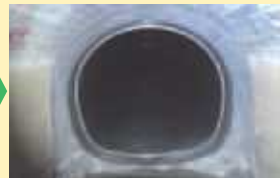
【改修後】(トンネル補強)
