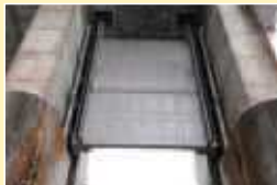
土砂吐ゲート 更新
