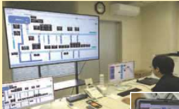
【改修後】 (中央管理所)
