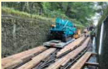
用水路内に軌条設備を敷設し、軌陸車や運搬台車により重機材や作業員を運搬
