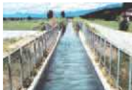
改修後の幹線用水路
