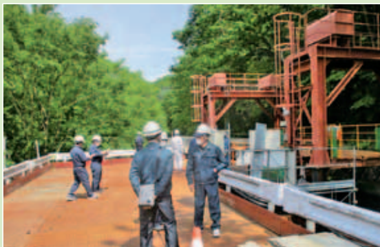
大広久内放水工の現況状況の確認
