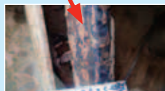
取水口の縦桁、開閉機の発錆状況
