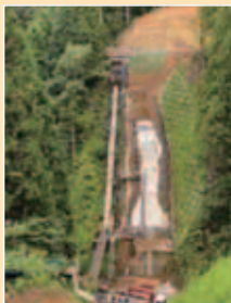
配管基礎施工中
