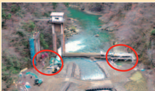
第1期工事 施工状況
