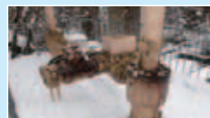
取水口の縦桁、開閉機の発錆状況
