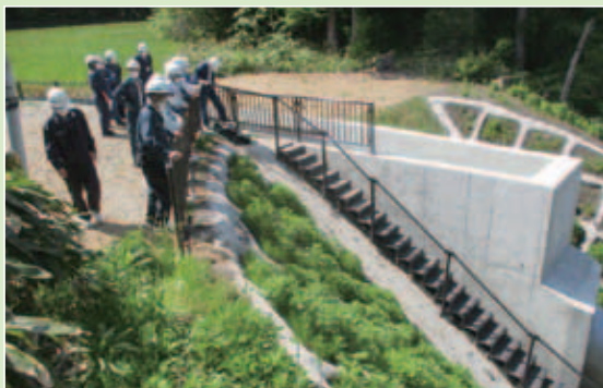
北沢サイホンの完成状況の確認
