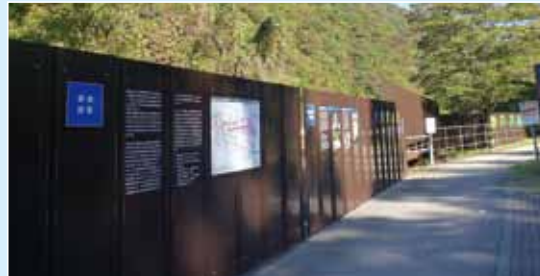
仮設道路の仮囲い（周辺景観に配慮した色彩、事業PRのための看板設置）
