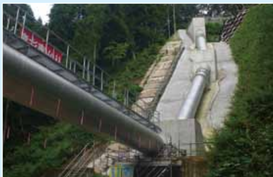
完成した北沢サイホン配管施設
