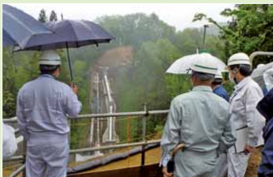
北沢サイホンの工事進捗状況の確認
