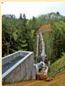
吐口水槽付近より
