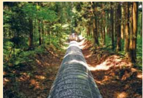
完成（ネットカバー設置）
