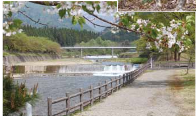
斉内川水管橋
