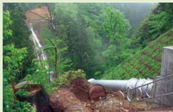
供用開始した北沢サイホン
