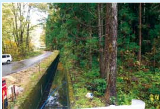
幹線用水路（仙北市角館町白岩地内）
