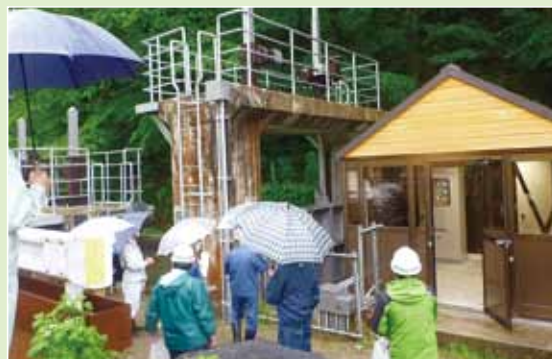
大広久内放流水の改修状況の確認
