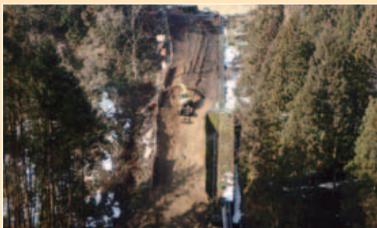
法面掘削状況（ロッククライミングマシン）遠景
