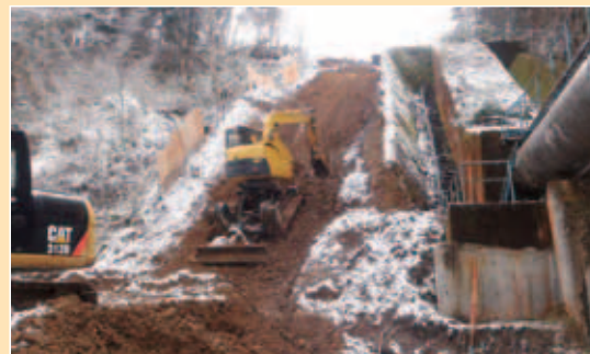
法面掘削状況（ロッククライミングマシン）近景
