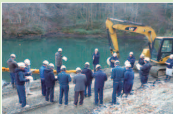
神代右岸取水口の工事概要説明
