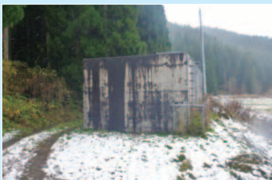
幹線用水路 (サイホン部)
