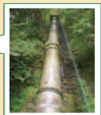
サイホン上流側斜面部
