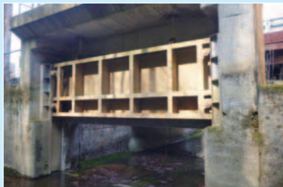
大広久内 放水ゲート
