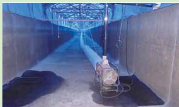
③ジェットヒーター、屋根を設置し、養生を行う
