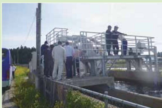
完成した田沢疏水幹線用水路千畑除塵機の説明
