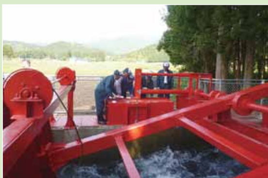
完成した田沢疏水幹線用水路高野水位調節ゲートの説明
