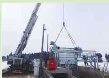
除塵機駆動装置の据付状況
