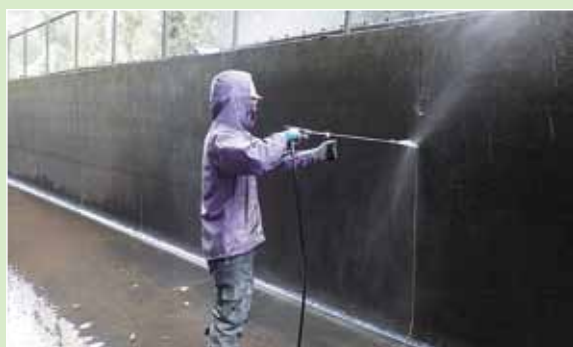
①水路洗浄工の状況
