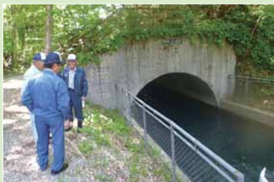
仙北市角館町広久内地区にて改修（目地補修）した田沢疏水左岸幹線水路の確認
