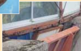
放水ゲート工事実施予定箇所の現状 (開閉機の腐食)
