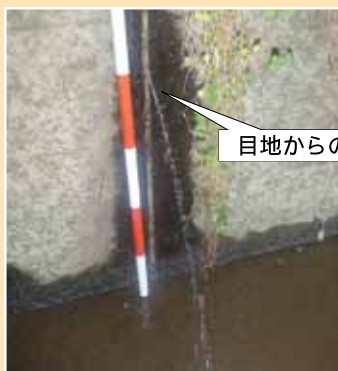
目地補修工事 実施予定箇所の 現状
