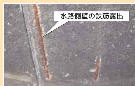
断面補修工事 実施予定箇所の 現状
