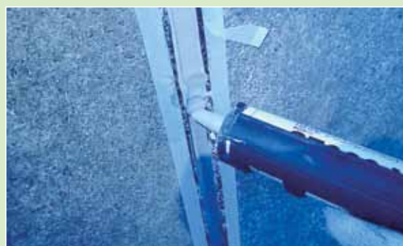
②老朽化した既設目地を撤去、シーリング材を充填
