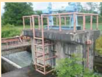
放水ゲート工事実施予定箇所の現状 (開閉機の腐食)
