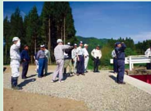
大仙市太田町川口地内でサイホン及び放流工ゲート工事の説明
