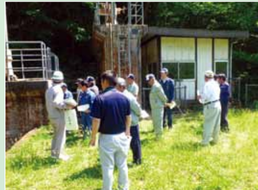
大広久内放水工で現在の取水状況を確認
