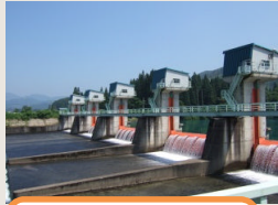
玉川頭首工 施設説明
