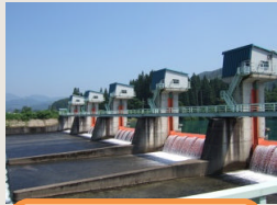
玉川頭首工 施設説明
