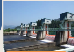
玉川頭首工 施設説明
