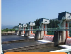
玉川頭首工 施設説明
