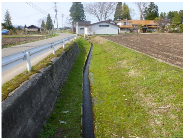
写真-1 御堰跡 (下流側から上流方向)
