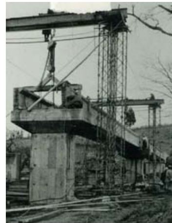
写真－6 建設中の斎藤川水路橋
