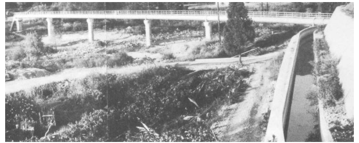
写真－5 完成当時の斎内川水管橋
