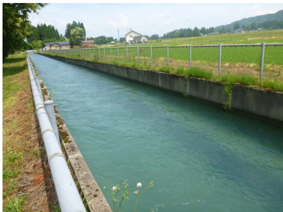
写真－7 現在の田沢疏水左岸幹線用水路
