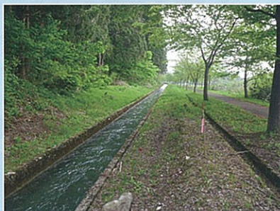
(第14号開渠～第15号開渠) L=0.5km
