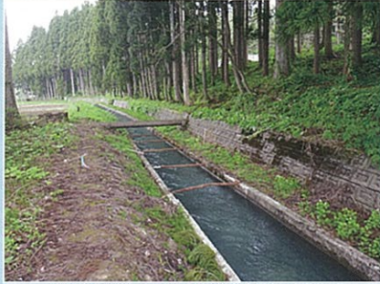
(第19号開渠～第20号開渠) L=0.3km
