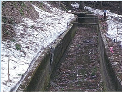
(第14号開渠～第15号開渠) L=0.5km
