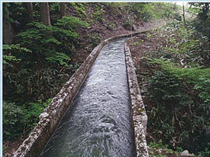
(第36号開渠～第6号横断工) 0.4 km
