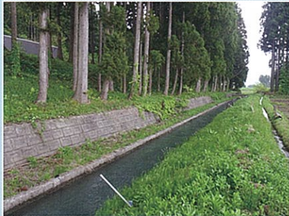
(金井伝沢サイフォン～三嶽サイフォン～第28号開渠) L=1.1km
